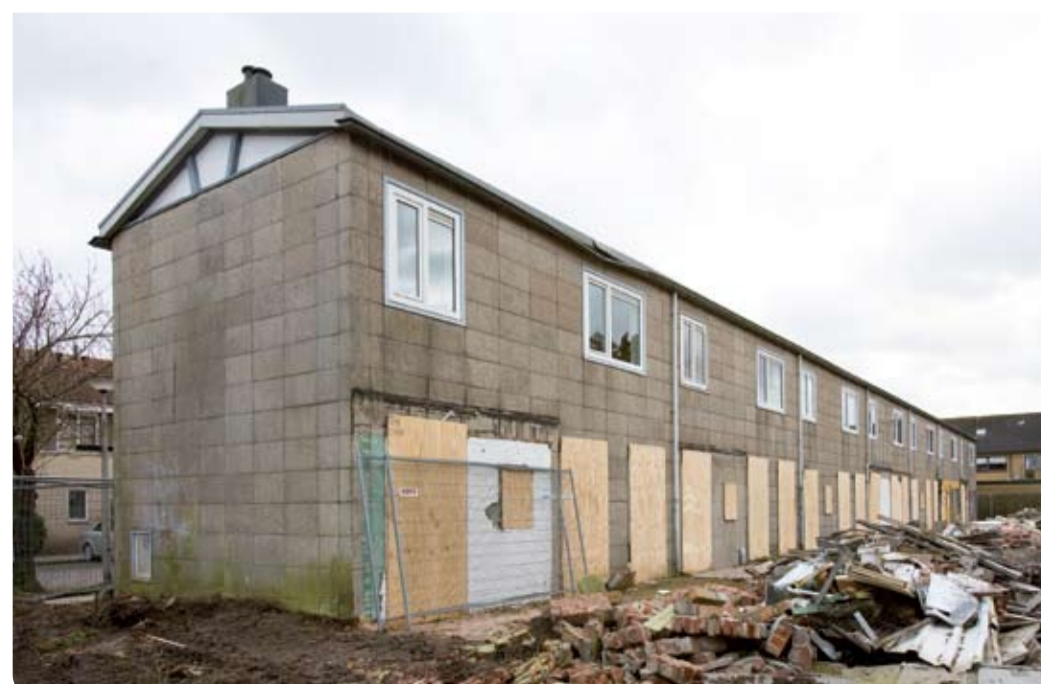
Deze woningen worden gesloopt, daarvoor in de plaats komen HuurWensWoningen.
